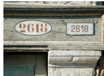
Old and new, Fondamenta della Misericordia, Venice
